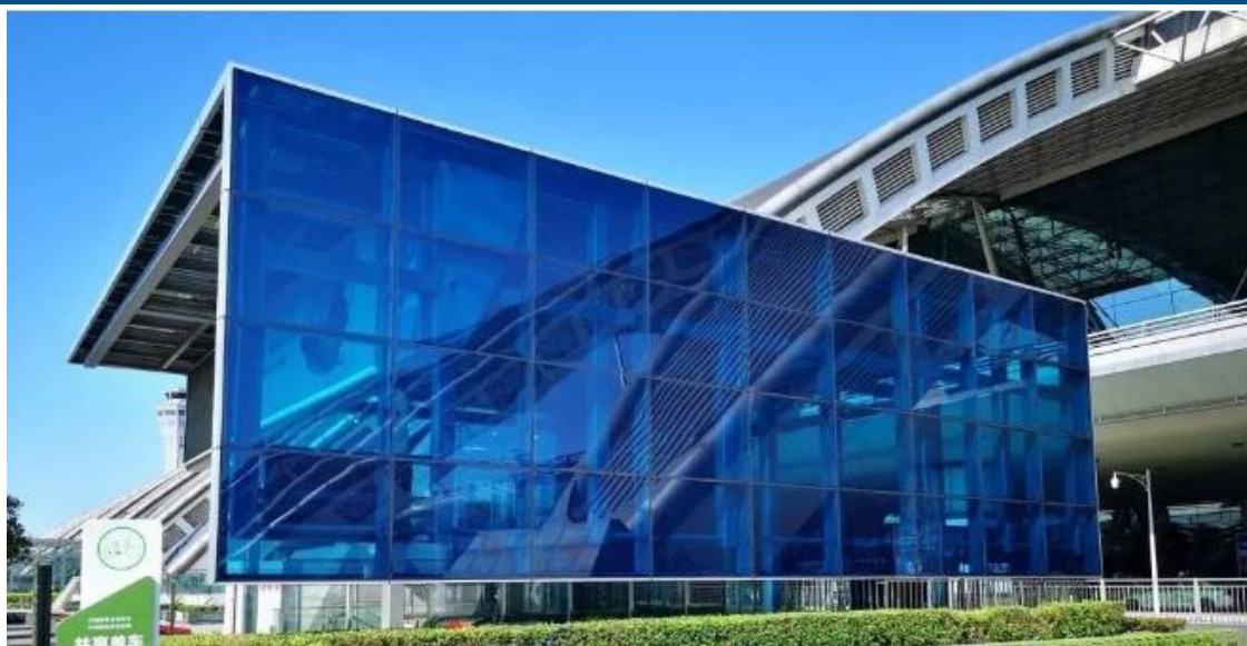
图表 9：成都双流国际机场 T2 航站楼 L1 通道碲化镉发电幕墙
