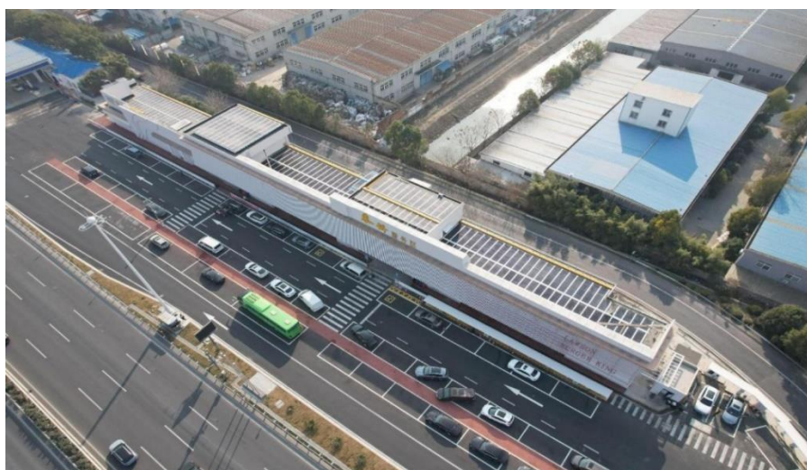
图表 8：上海首个绿色低碳高速公路服务区——朱桥服务区采用“光伏+高速”的设计方案
