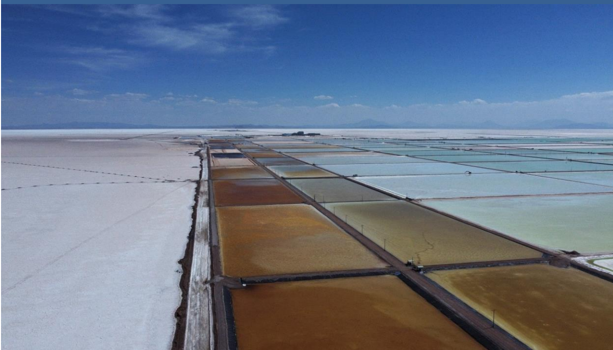
位于玻利维亚波托西的乌尤尼盐沼，用于提取锂的蒸发池
